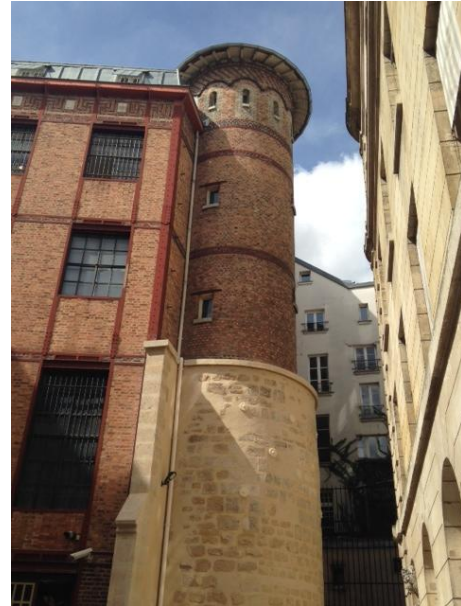
Soubassement de la tour de l'enceinte de Philippe Auguste
